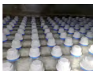
Düsenboden nach DIN 19643/ÖNORM 6216
